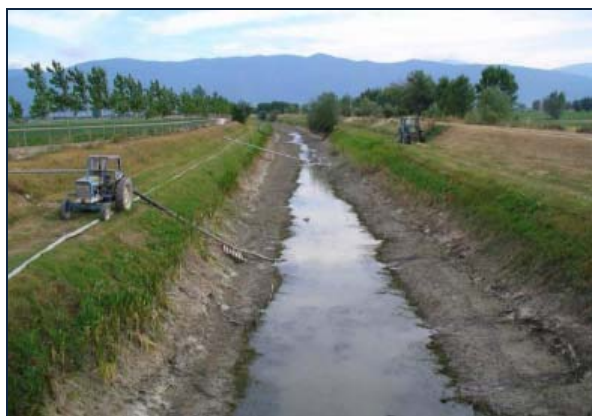
Figura 84. Esempio di prelievo della risorsa idrica ai fini irrigui dai canali della Piana mediante impianti mobili di sollevamento collegati alle macchine agricole.
